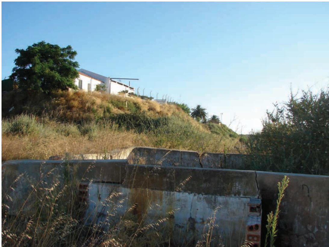
Detalle de las construcciones sobre la paleoterraza.
